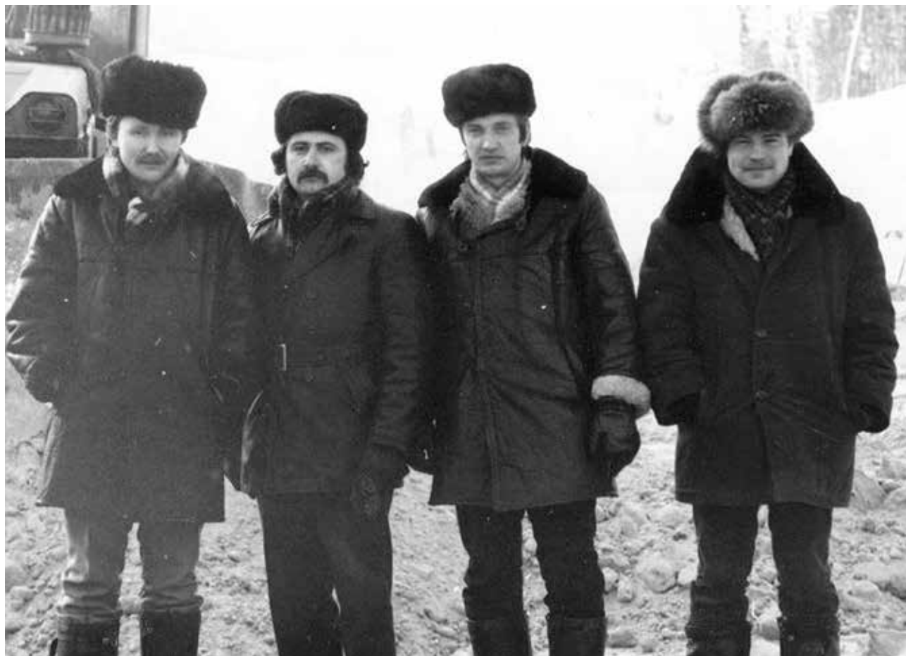
80-е годы. Слева направо: Горкунов Н. — нач. участка СУ-909 (ген. директор СУ-909 с 1994 по 2004 год), Приходько А. — начальник ПТО СУ-909, Чернов Г. — мастер, Андреев А. — прораб мехколонны № 129 треста «НижневартовскДорСтрой» (в настоящее время генеральный директор АО «ДСК «АВТОБАН»).
